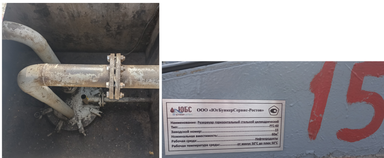
Рисунок 2 – Люк резервуара РГС-60 зав.№15 с указанием места нанесения заводского номера
