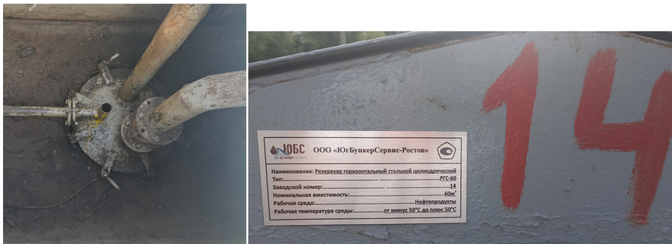
Рисунок 1 – Люк резервуара РГС-60 зав.№14 с указанием места нанесения заводского номера
