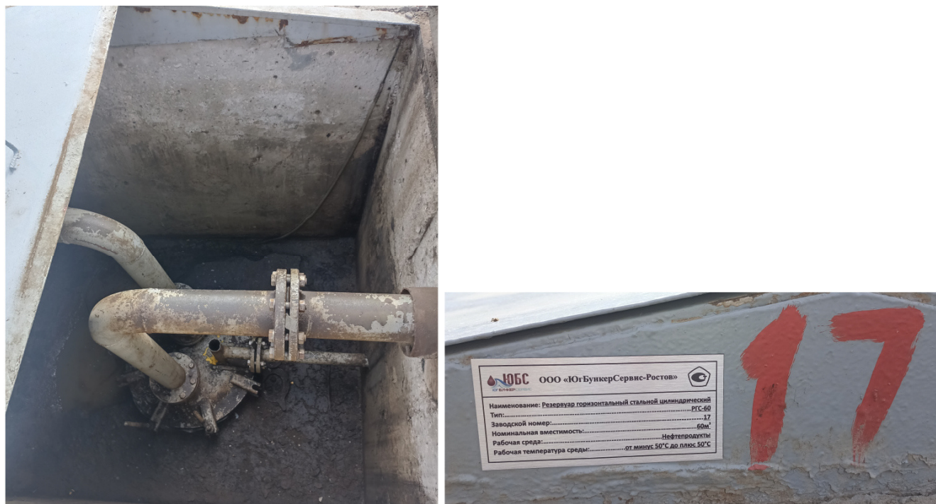
Рисунок 4 – Люк резервуара РГС-60 зав.№17 с указанием места нанесения заводского номера
