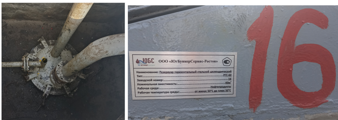
Рисунок 3 – Люк резервуара РГС-60 зав.№16 с указанием места нанесения заводского номера
