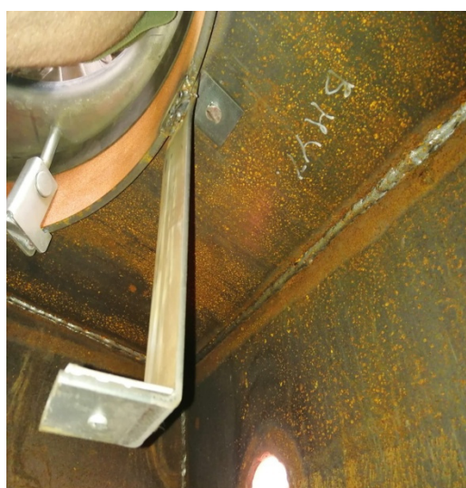
Рисунок 6 – Способ монтажа указателя уровня налива
