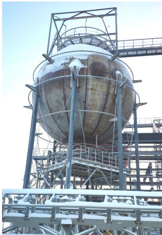
Рисунок 1 - Общий вид резервуара РШС-600
