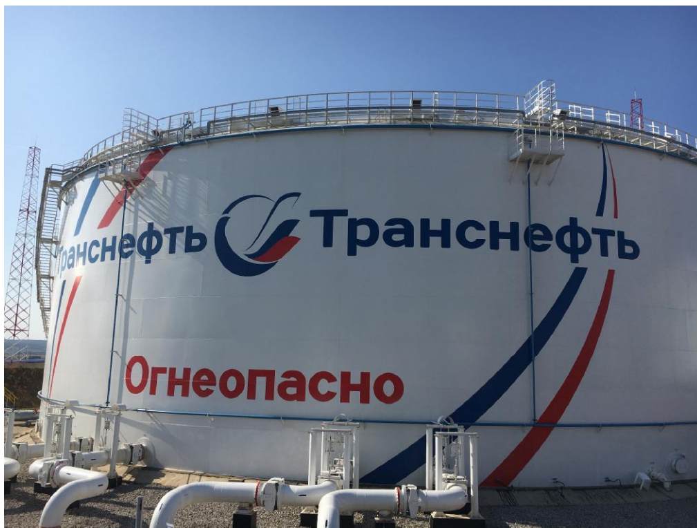
Рисунок 3 - Общий вид резервуаров вертикальных стальных цилиндрических РВСП-20000
