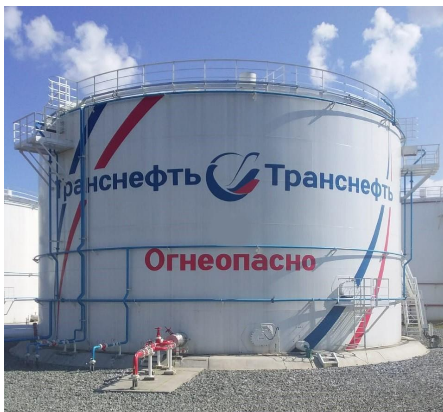
Рисунок 2 - Общий вид резервуаров вертикальных стальных цилиндрических РВСП-5000
