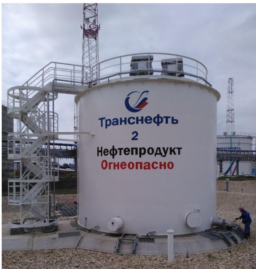
Рисунок 1 - Общий вид резервуаров вертикальных стальных цилиндрических РВС-400
