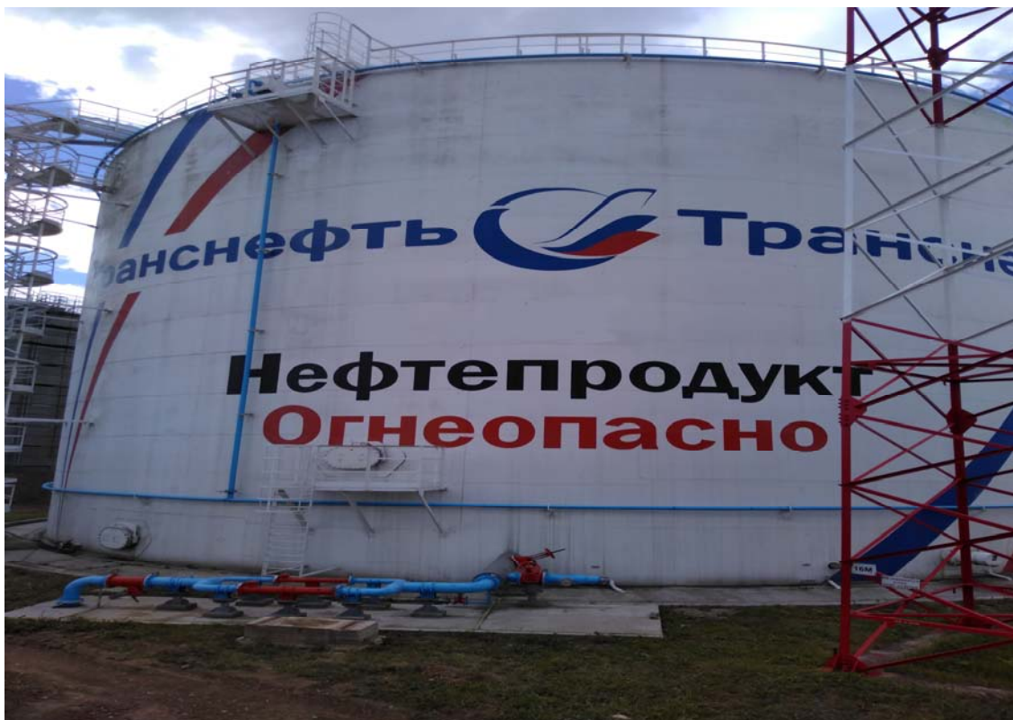
Рисунок 6 - Общий вид резервуаров вертикальных стальных цилиндрических РВСП-10000
