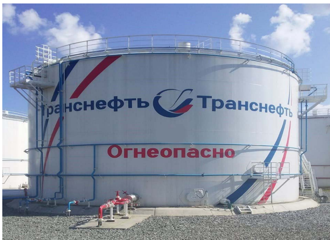
Рисунок 5 - Общий вид резервуаров вертикальных стальных цилиндрических РВСП-5000
