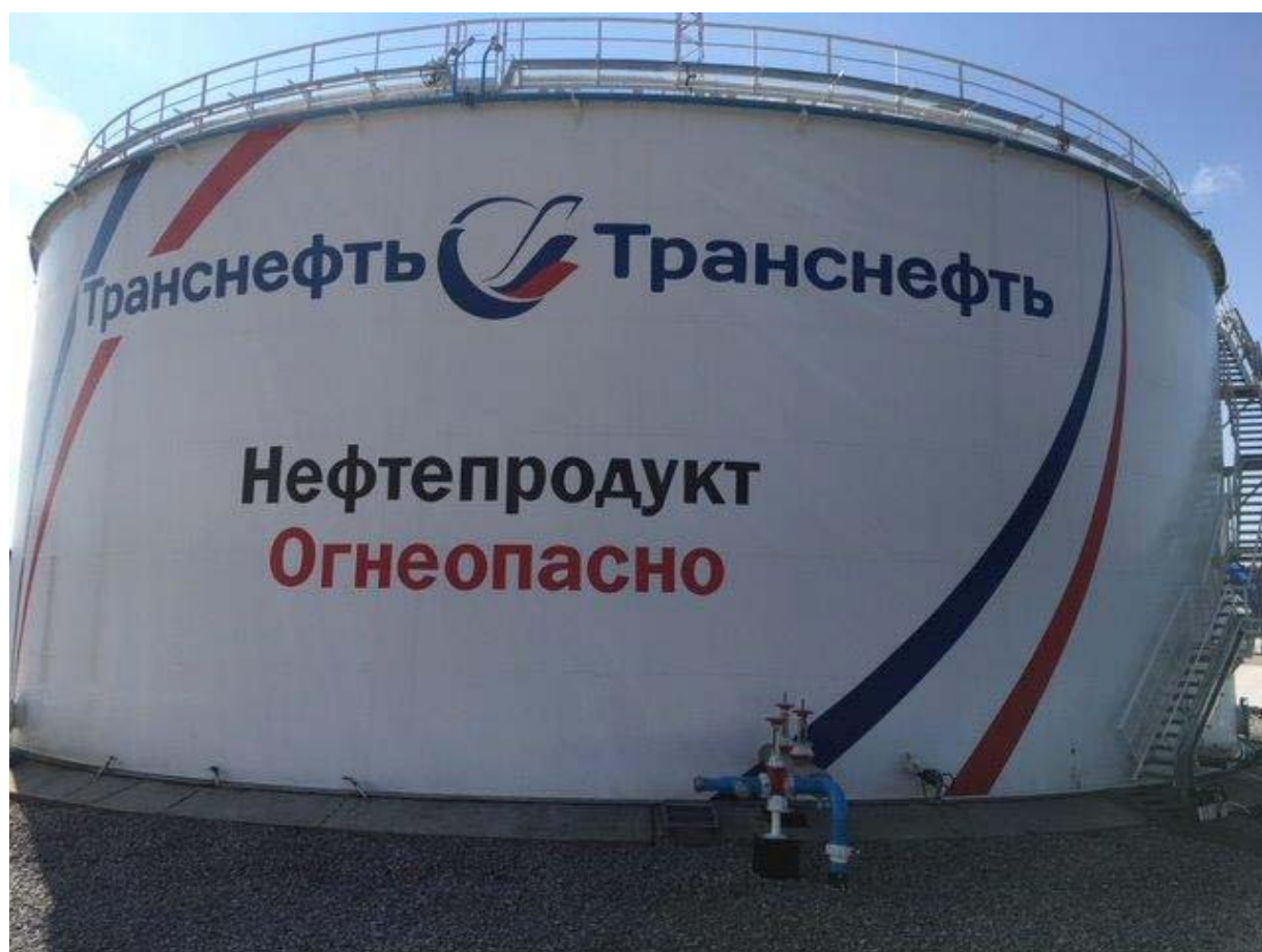
Рисунок 3 - Общий вид резервуаров вертикальных стальных цилиндрических РВС-10000
