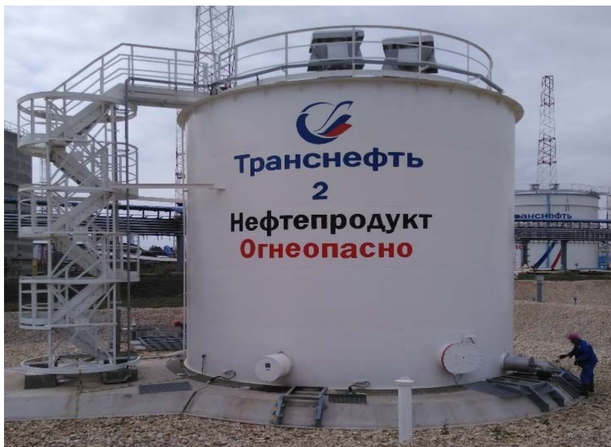
Рисунок 1 - Общий вид резервуаров вертикальных стальных цилиндрических РВС-400
