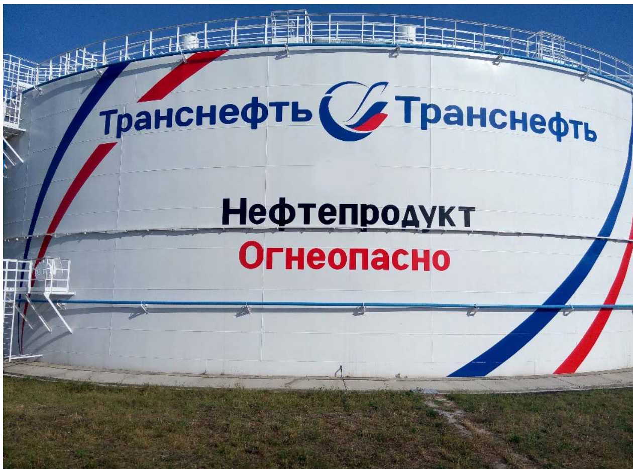
Рисунок 4 - Общий вид резервуаров вертикальных стальных цилиндрических РВС-20000
