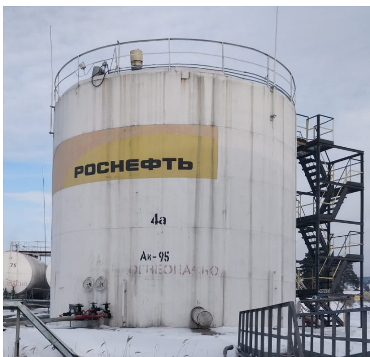
Рисунок 1 – Общий вид резервуара РВС-400
