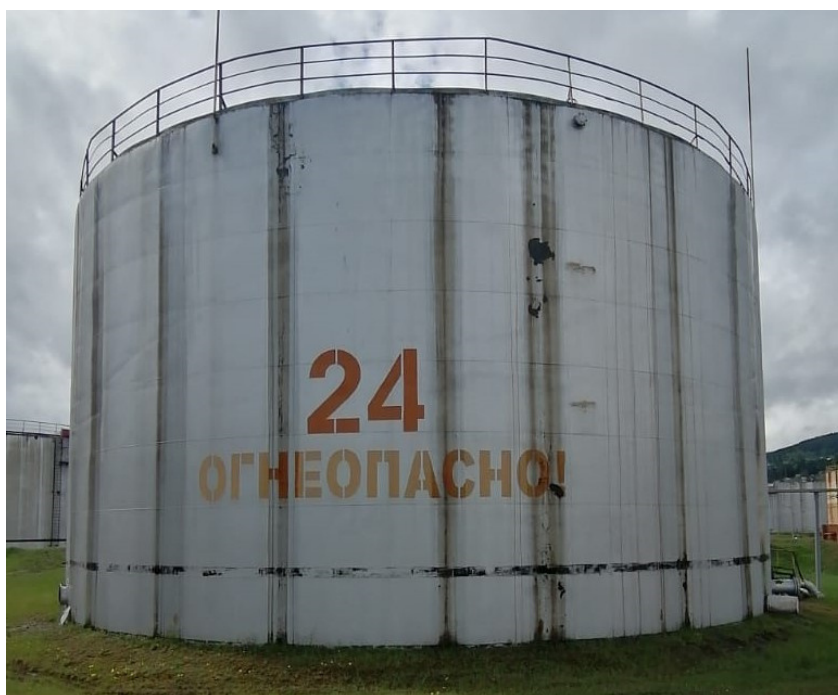
Рисунок 1 – Общий вид резервуаров РВС-5000
