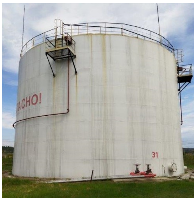
Рисунок 1 – Общий вид резервуаров РВС-3000
