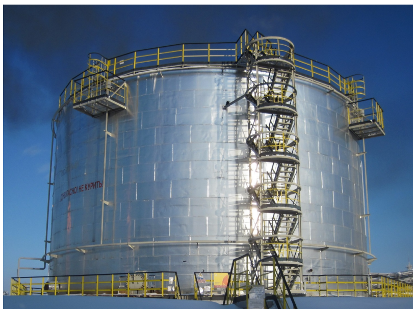
Рисунок 1 – Общий вид резервуара РВС-5000
