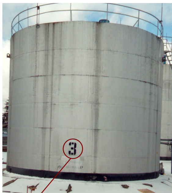
Рисунок 1 – Общий вид резервуара РВС-700 №2 с указанием места нанесения заводского номера
