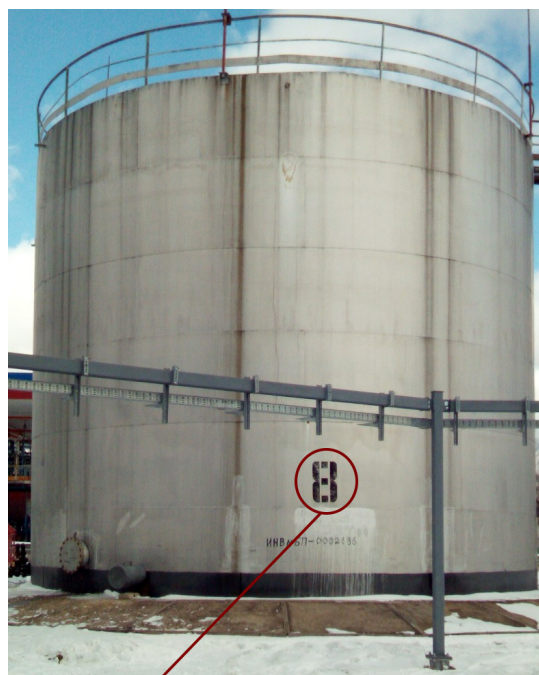
Рисунок 3 – Общий вид резервуара РВС-700 №7 с указанием места нанесения заводского номера
