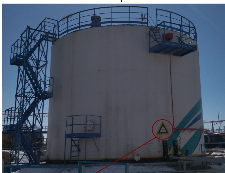
Рисунок 2 – Общий вид резервуара РВСП-1000 №38 с указанием места нанесения заводского номера
