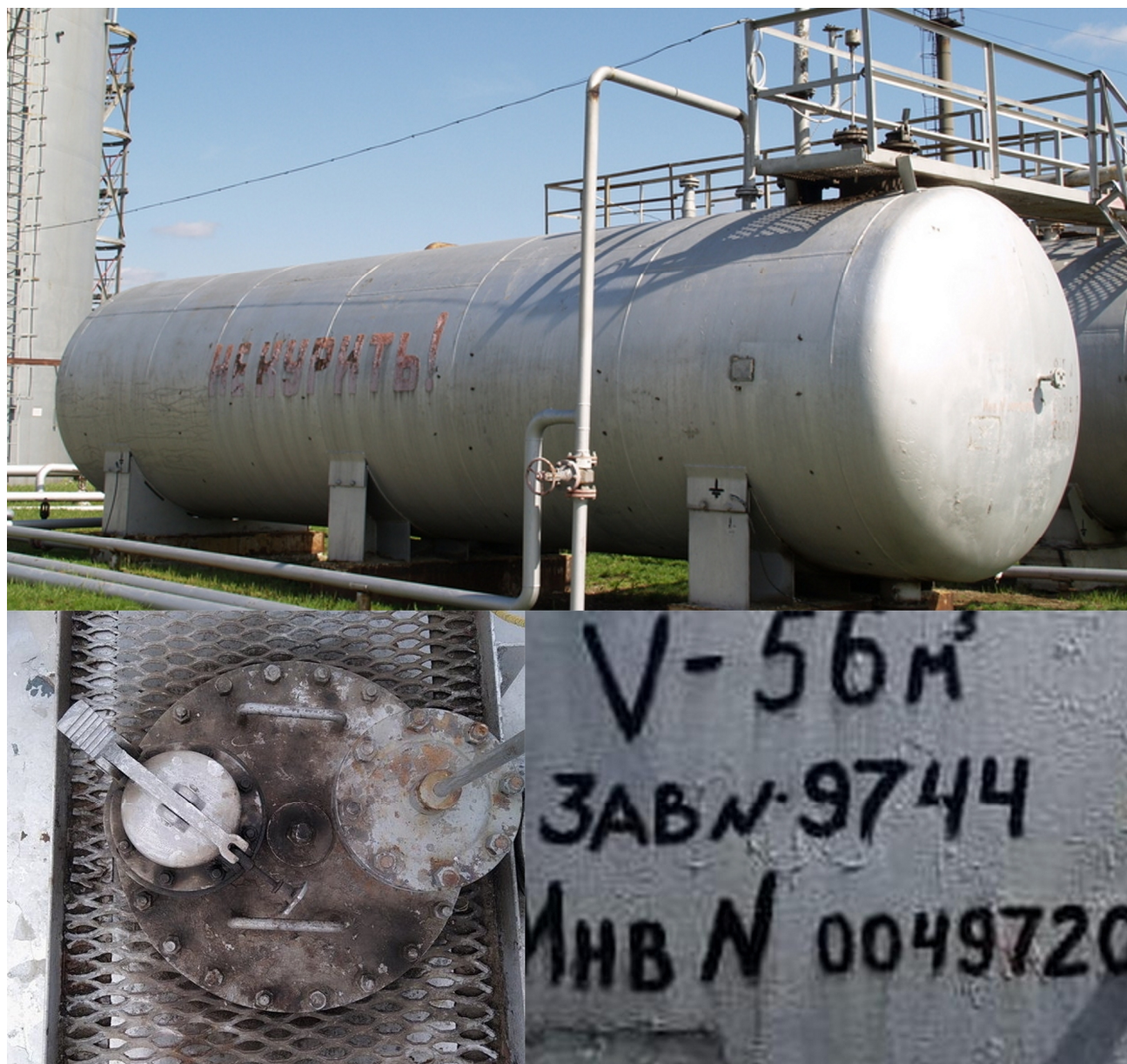
Рисунок 1 – Общий вид резервуара горизонтального цилиндрического РГС-56, горловины и заводского номера
