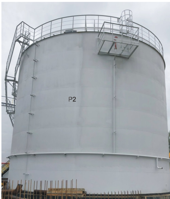
Рисунок 2 – Общий вид резервуара РВС-2000 зав.№ Р2
