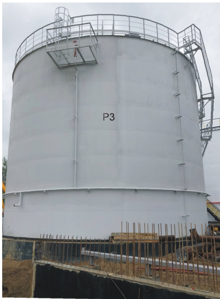
Рисунок 3 – Общий вид резервуара РВС-2000 зав.№ Р3
