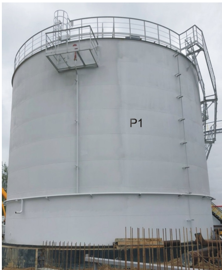
Рисунок 1 – Общий вид резервуара РВС-2000 зав.№ Р1
