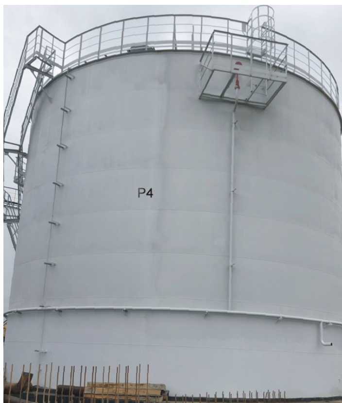
Рисунок 4 – Общий вид резервуара РВС-2000 зав.№ Р4
