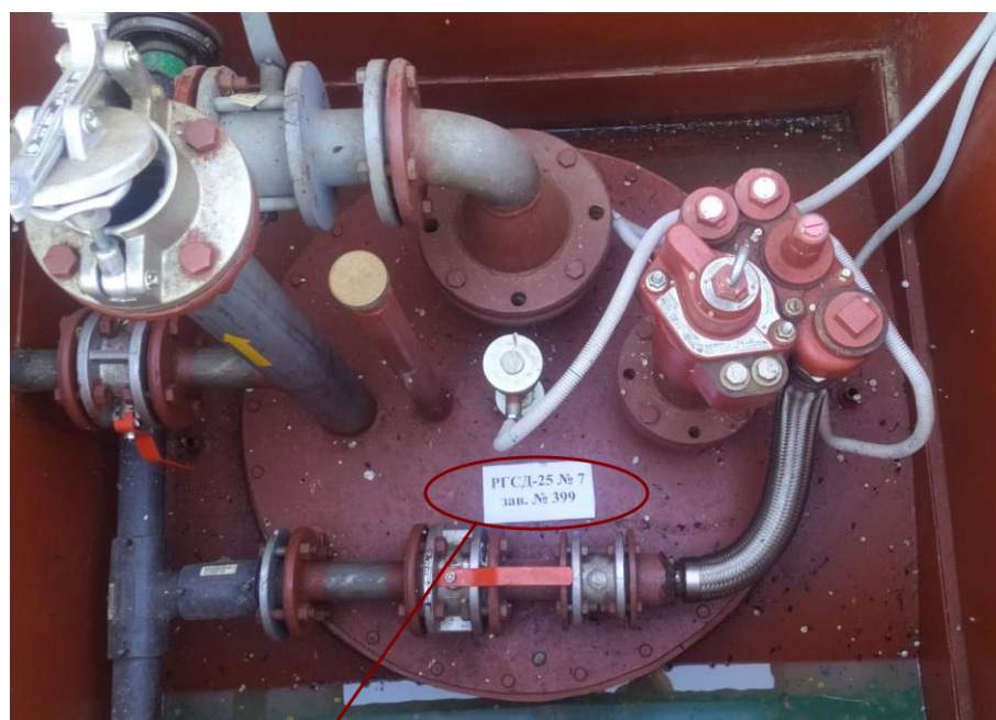
Рисунок 1 – Общий вид резервуара РГСД-25 зав.№ 384 с указанием места нанесения заводского номера
