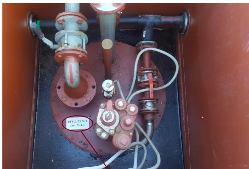
Рисунок 7 – Общий вид резервуара РГСД-25 зав.№ 406 с указанием места нанесения заводского номера
