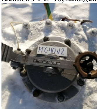
Рисунок 3 – Фотография горловины и заводского номера резервуара стального горизонтального цилиндрического РГС-40, заводской номер 2
