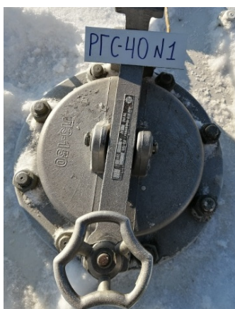
Рисунок 2 – Фотография горловины и заводского номера резервуара стального горизонтального цилиндрического РГС-40, заводской номер 1
