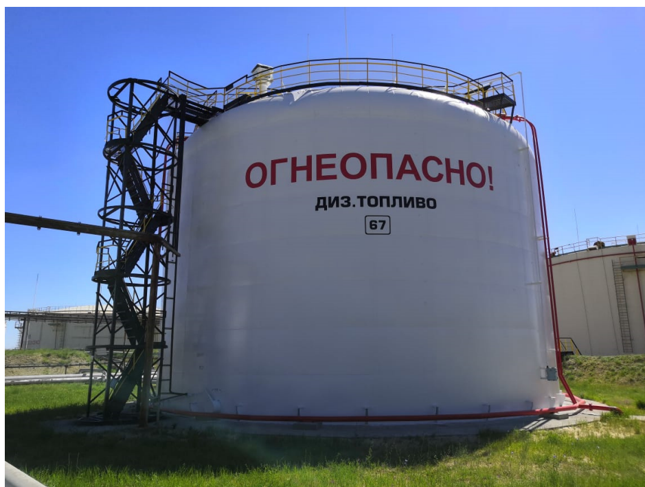
Рисунок 1 – Общий вид резервуара РВС-3000
