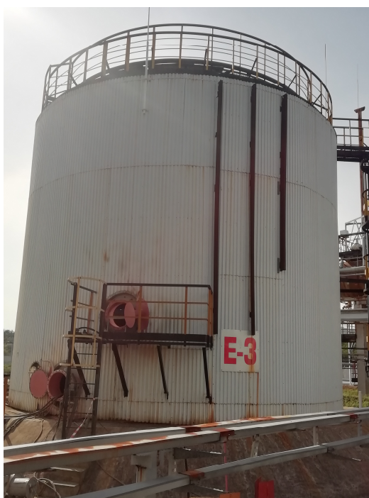
Рисунок 1 – Общий вид резервуара РВСП-700
