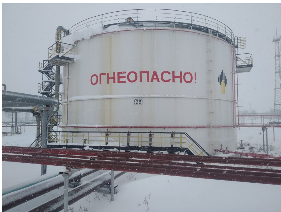
Рисунок 1 – Общий вид резервуара РВС-5000
