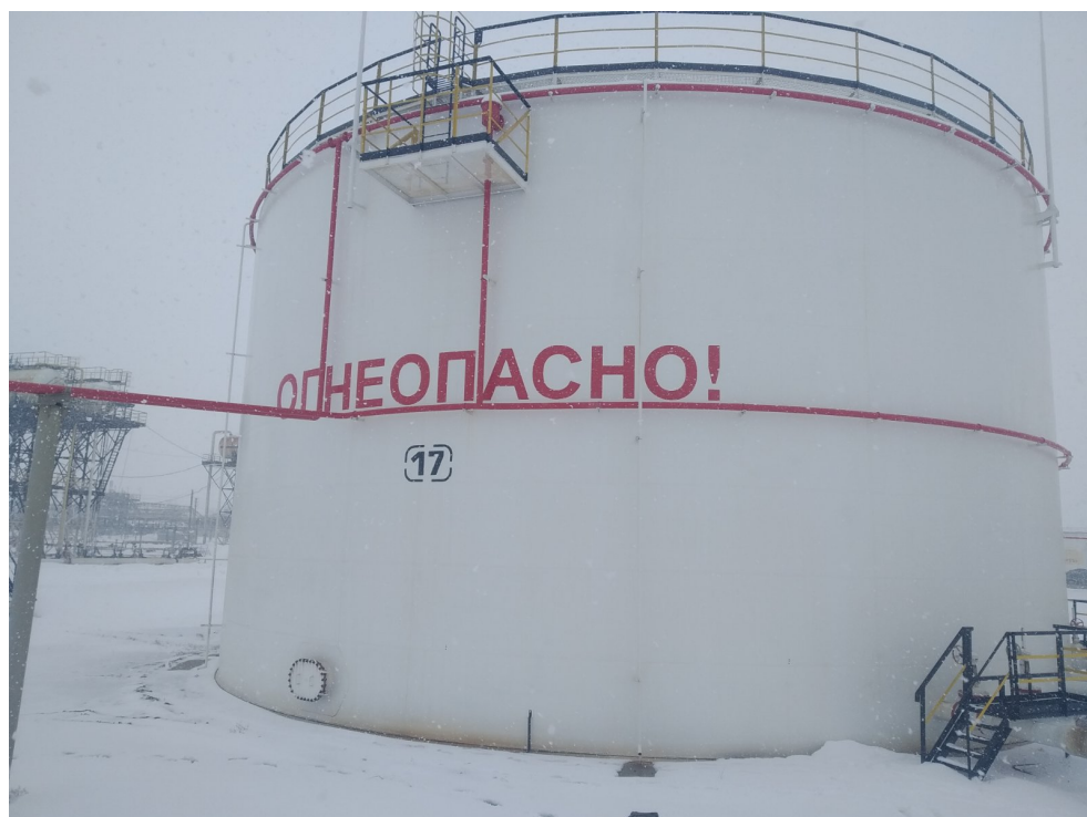
Рисунок 1 – Общий вид резервуара РВС-5000
