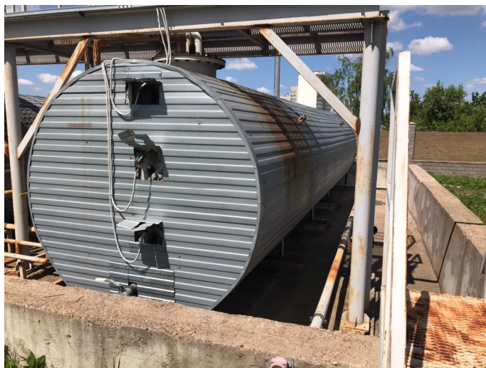
Рисунок 1 - Общий вид резервуаров стальных горизонтальных цилиндрических РГС-50
