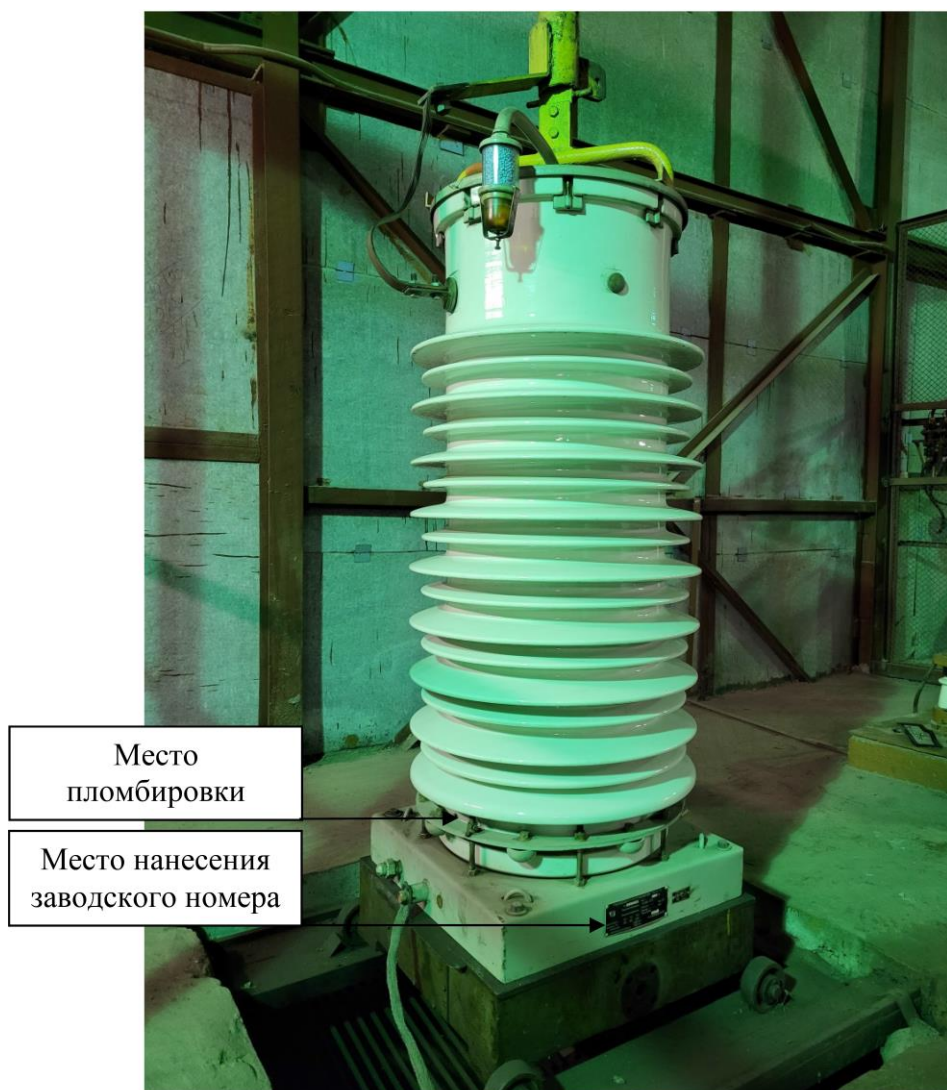
Рисунок 1. Общий вид средства измерений с указанием места пломбировки, места нанесения заводского номера
