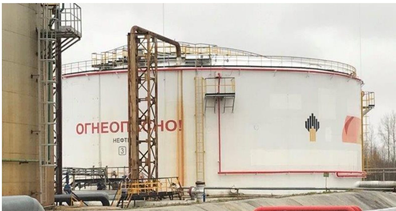
Рисунок 1 – Общий вид резервуаров РВС-10000
