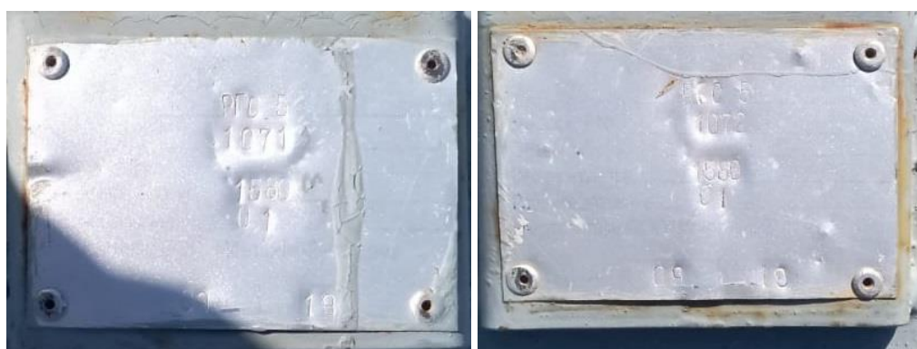
Рисунок 3 – Фотографии металлических шильдиков резервуаров с заводскими номерами
