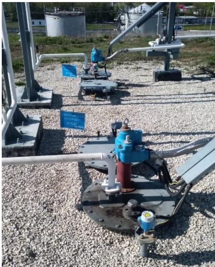
Рисунок 2 – Фотографии горловин и замерных люков резервуаров
