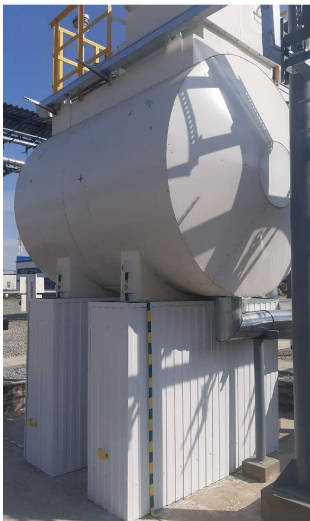
Рисунок 2 – Общий вид резервуара РГС-10
