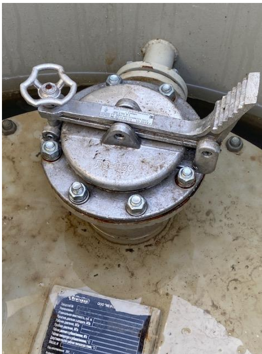
Рисунок 2 – Горловины и замерный люк резервуара.
