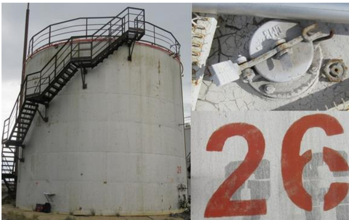
Рисунок 1 – Общий вид резервуара РВС-700 заводской номер 26
