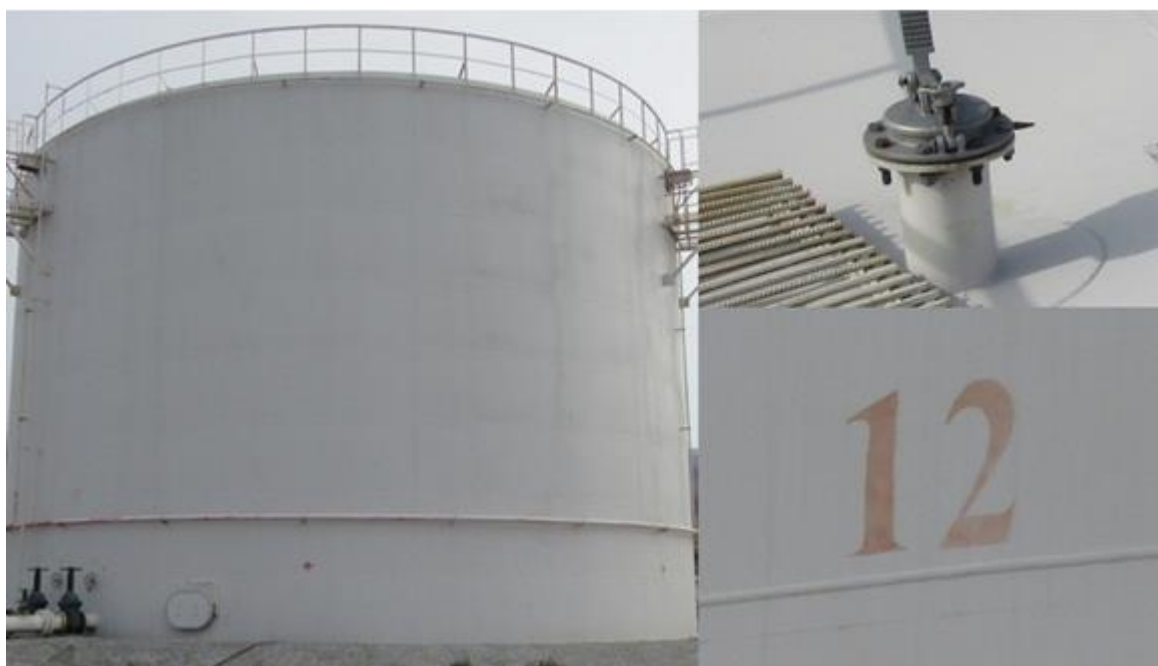
Рисунок 2 – Общий вид резервуара РВС-3000 заводской номер 12
