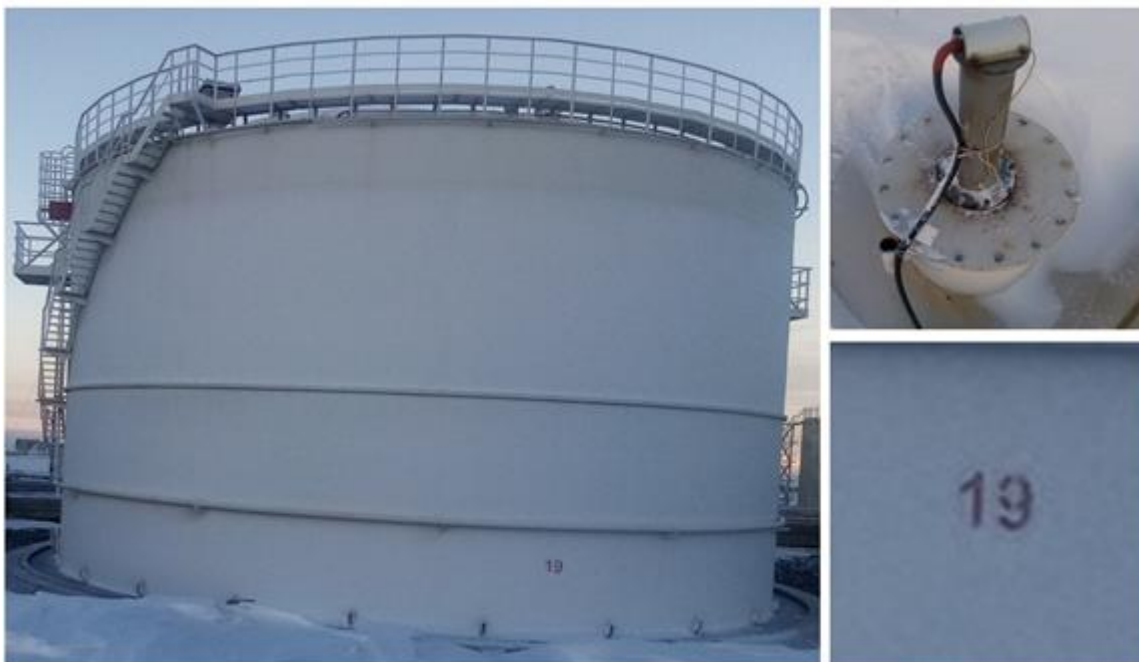
Рисунок 3 – Общий вид резервуара РВС-5000 заводской номер 19
