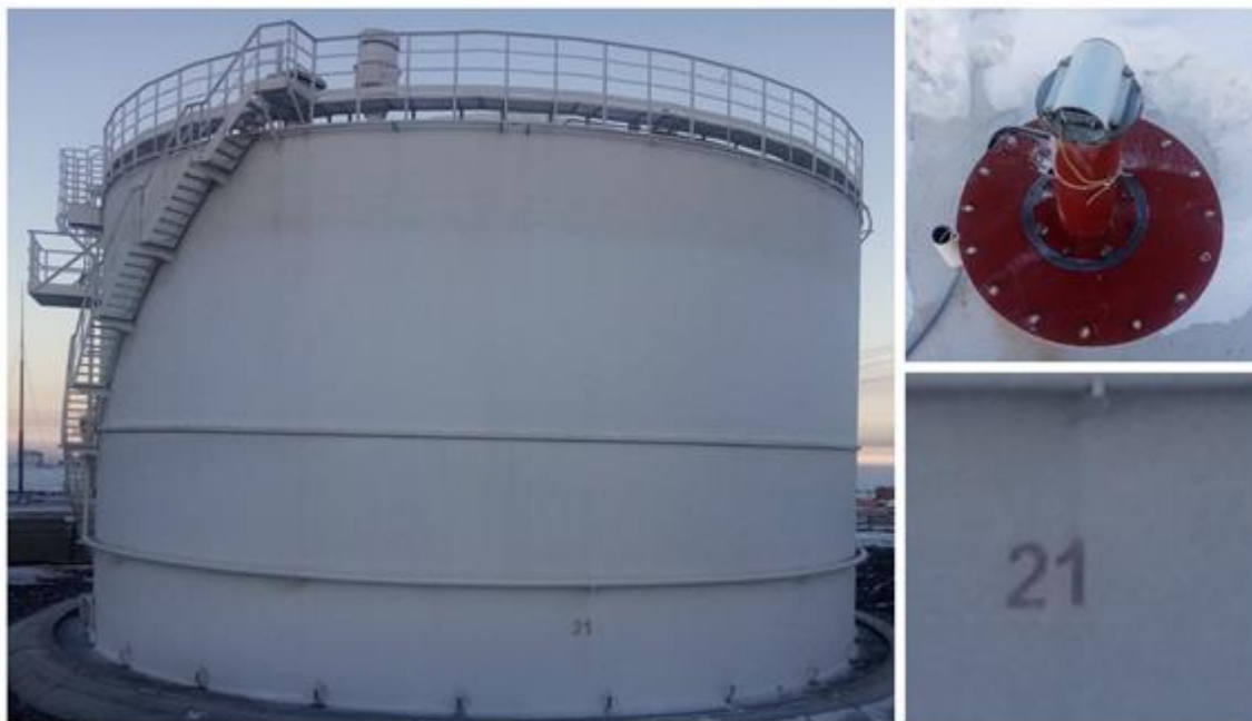
Рисунок 5 – Общий вид резервуара РВС-5000 заводской номер 21
