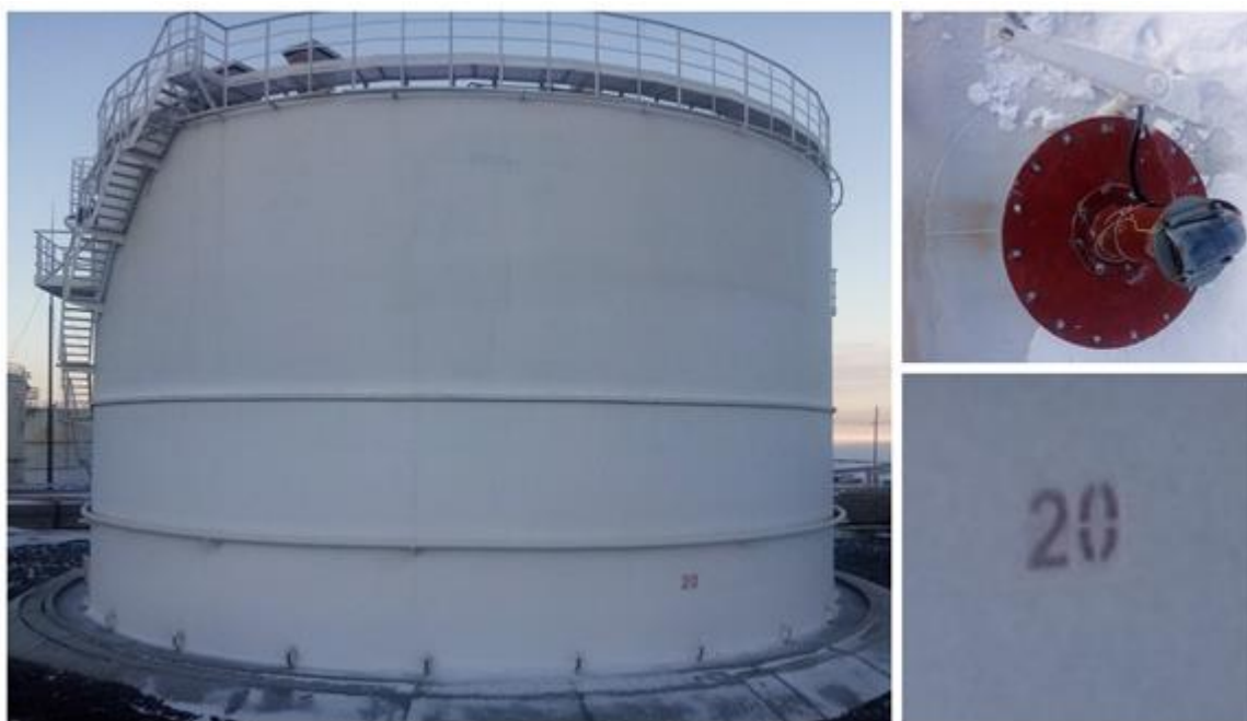
Рисунок 4 – Общий вид резервуара РВС-5000 заводской номер 20
