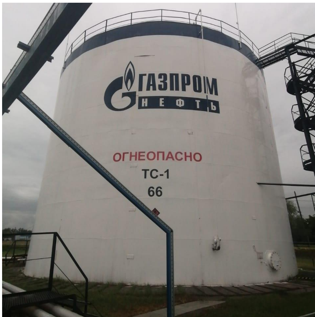
Рисунок 1 – Общий вид резервуара РВС-2000
