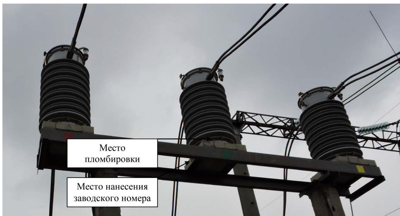
Рисунок 1. Общий вид средства измерений с указанием места пломбировки, места нанесения заводского номера
