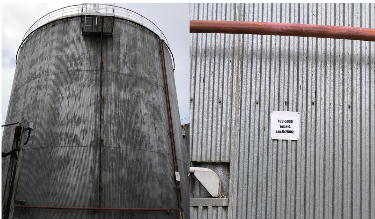
Рисунок 4 - Общий вид резервуара стального вертикального цилиндрического теплоизолированного PBC-5000, заводской № 25061
