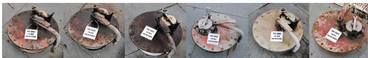
Рисунок 1 - Общий вид горловин и замерных люков резервуаров стальных вертикальных цилиндрических теплоизолированных РВС-5000, заводские №№ 25059, 25060, 25061, 25062, 25063, 25064
