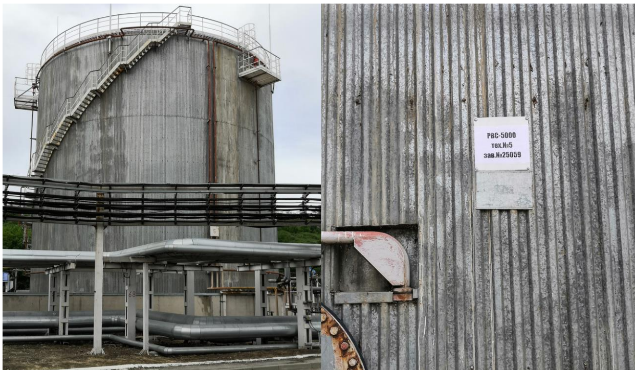
Рисунок 2 - Общий вид резервуара стального вертикального цилиндрического теплоизолированного PBC-5000, заводской № 25059
