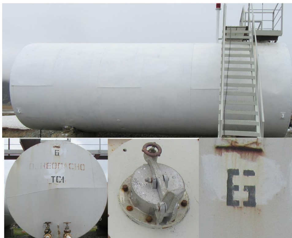
Рисунок 5 - Общий вид резервуара РГС-75 №6
