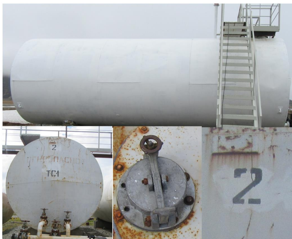
Рисунок 4 - Общий вид резервуара РГС-75 №2
