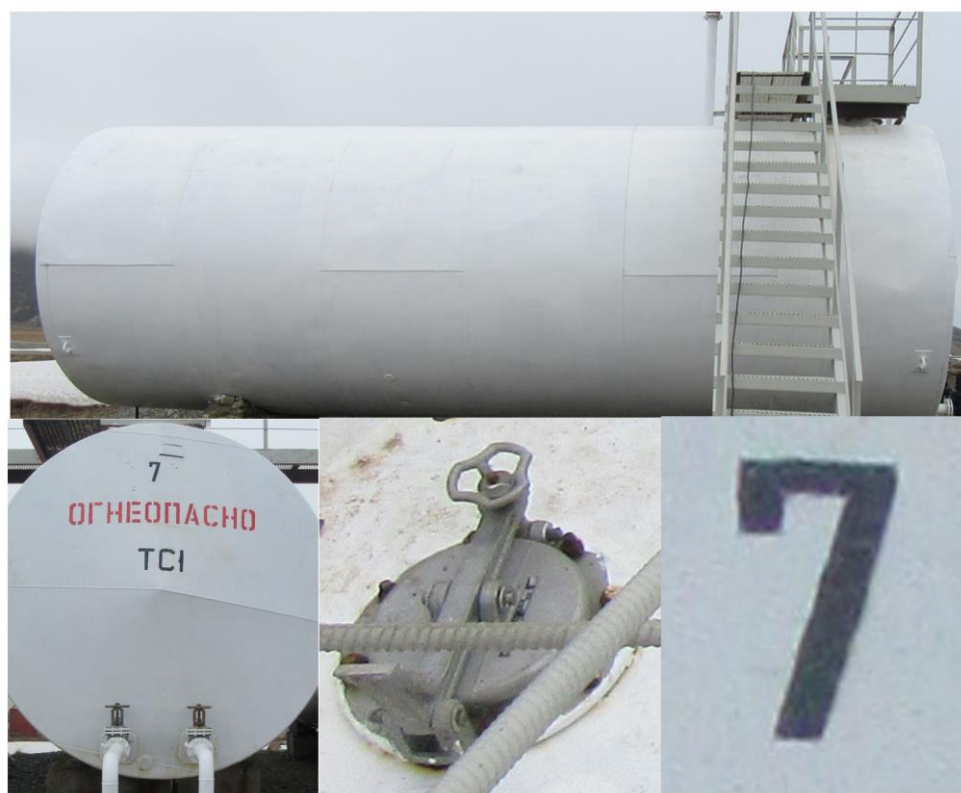
Рисунок 6 - Общий вид резервуара РГС-75 №7
