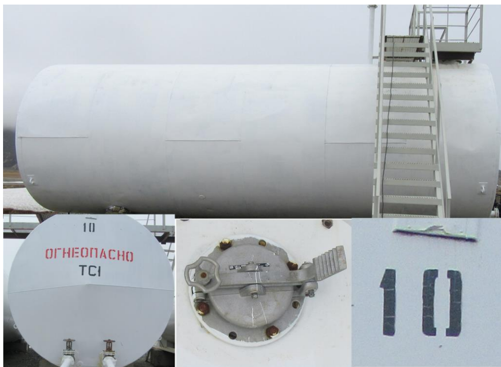
Рисунок 9 - Общий вид резервуара РГС-75 №10
