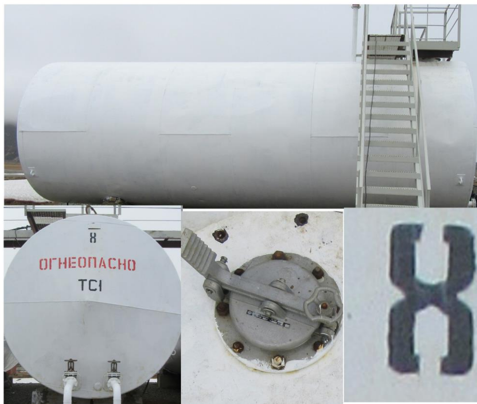
Рисунок 7 - Общий вид резервуара РГС-75 №8
