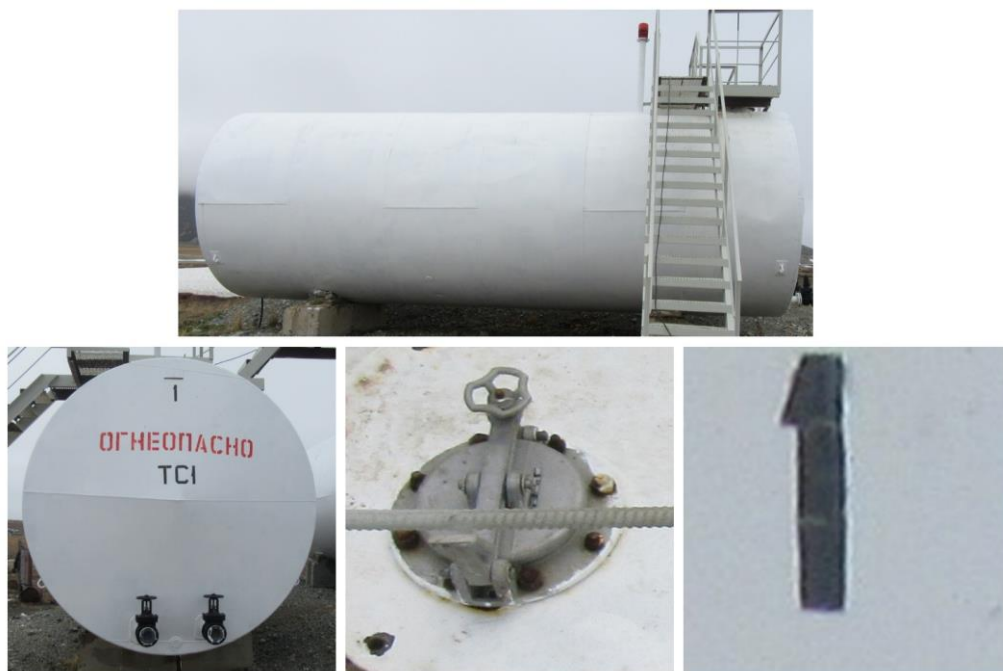
Рисунок 3 - Общий вид резервуара РГС-75 №1
