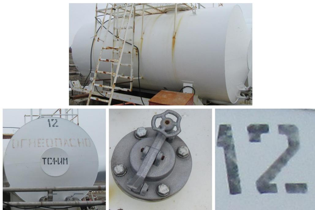
Рисунок 2 - Общий вид резервуара РГС-15 №12
