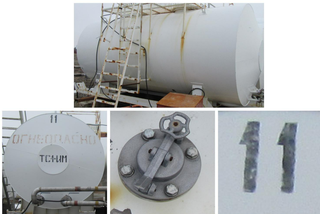
Рисунок 1 - Общий вид резервуара РГС-15 №11
