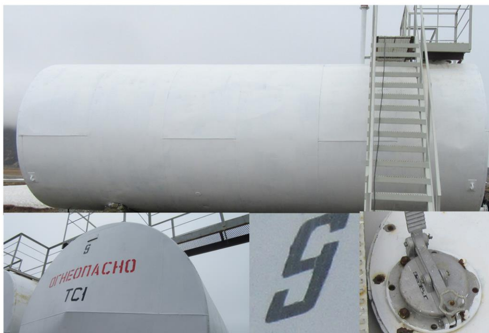
Рисунок 8 - Общий вид резервуара РГС-75 №9
