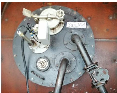
Рисунок 1 – Общий вид резервуара РГС-30
