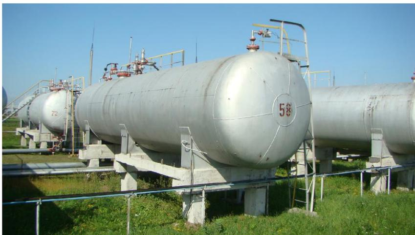
Рисунок 1 - Общий вид резервуаров стальных горизонтальных цилиндрических РГС-100
