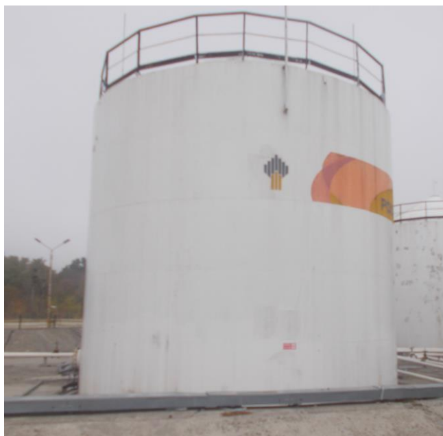
Рисунок 1 – Общий вид резервуаров РВС-400
