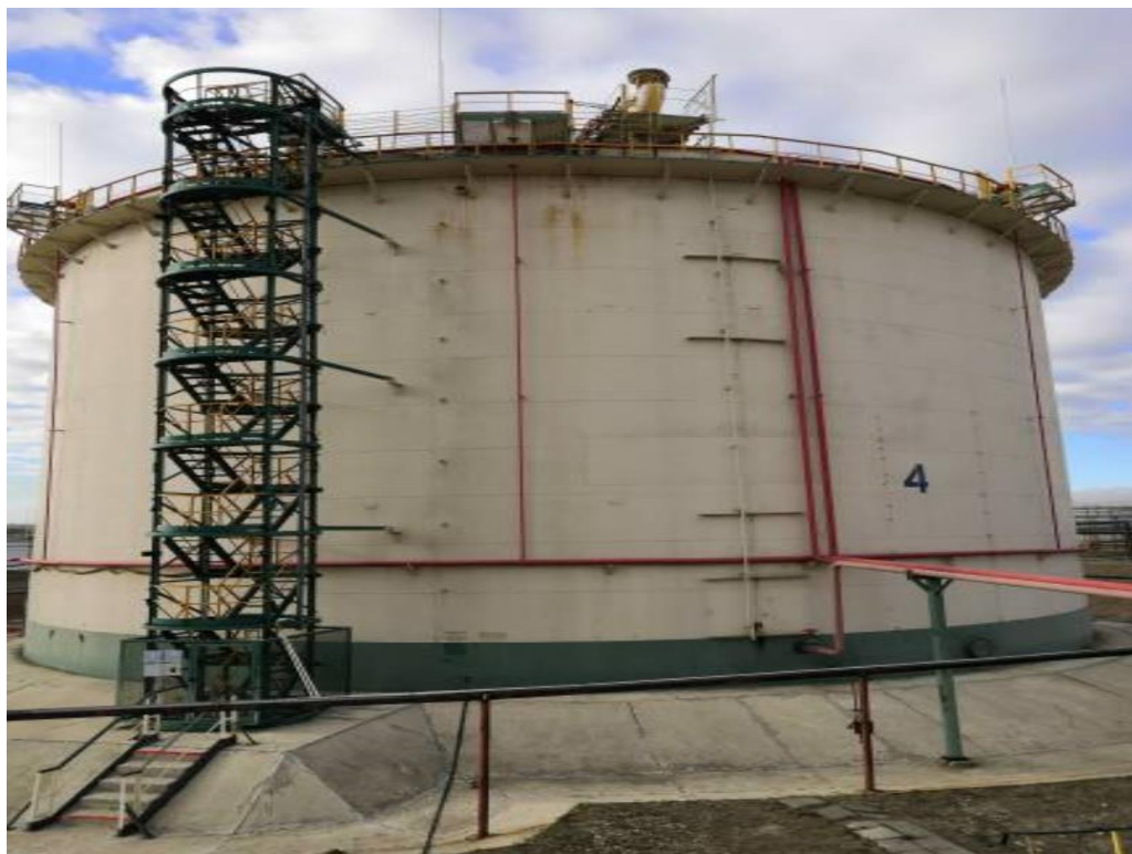
Рисунок 7 – Общий вид резервуаров РВСПК-10000
