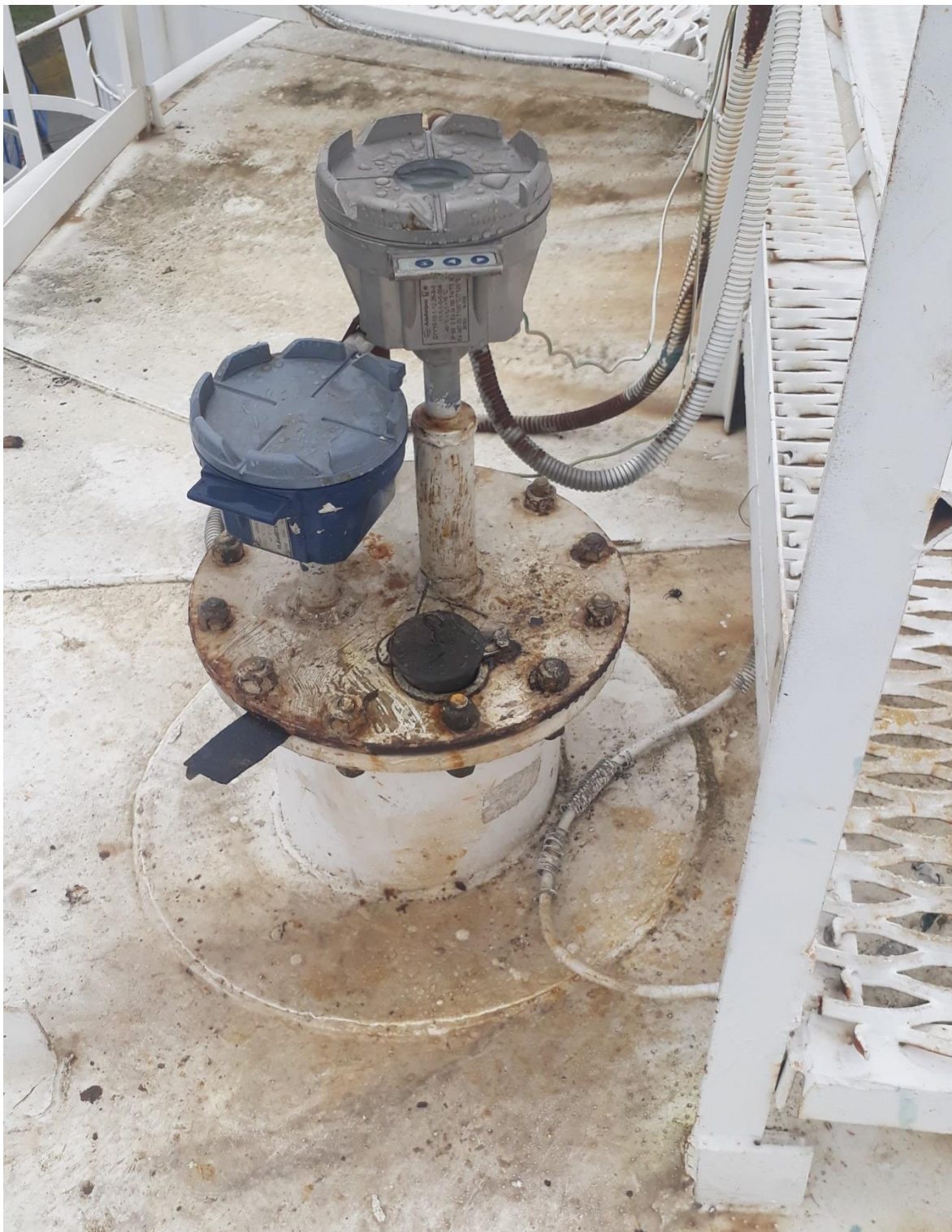
Рисунок 3- Фотография крышки замерного люка резервуара вертикального стального цилиндрического с понтоном РВСП-1000 заводской номер 92.
