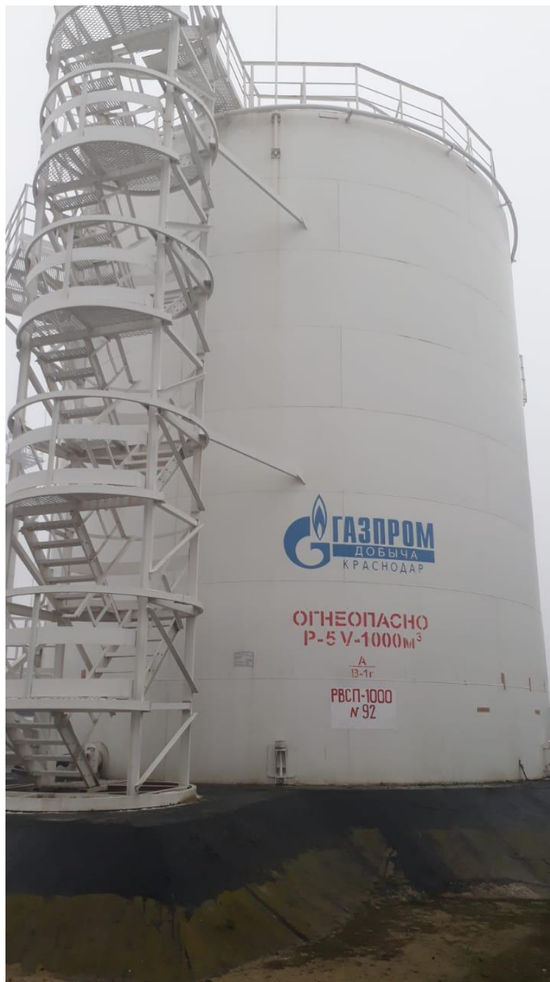
Рисунок 2 - Фотография общего вида резервуара вертикального стального цилиндрического с понтоном РВСП-1000 заводской номер 92.
