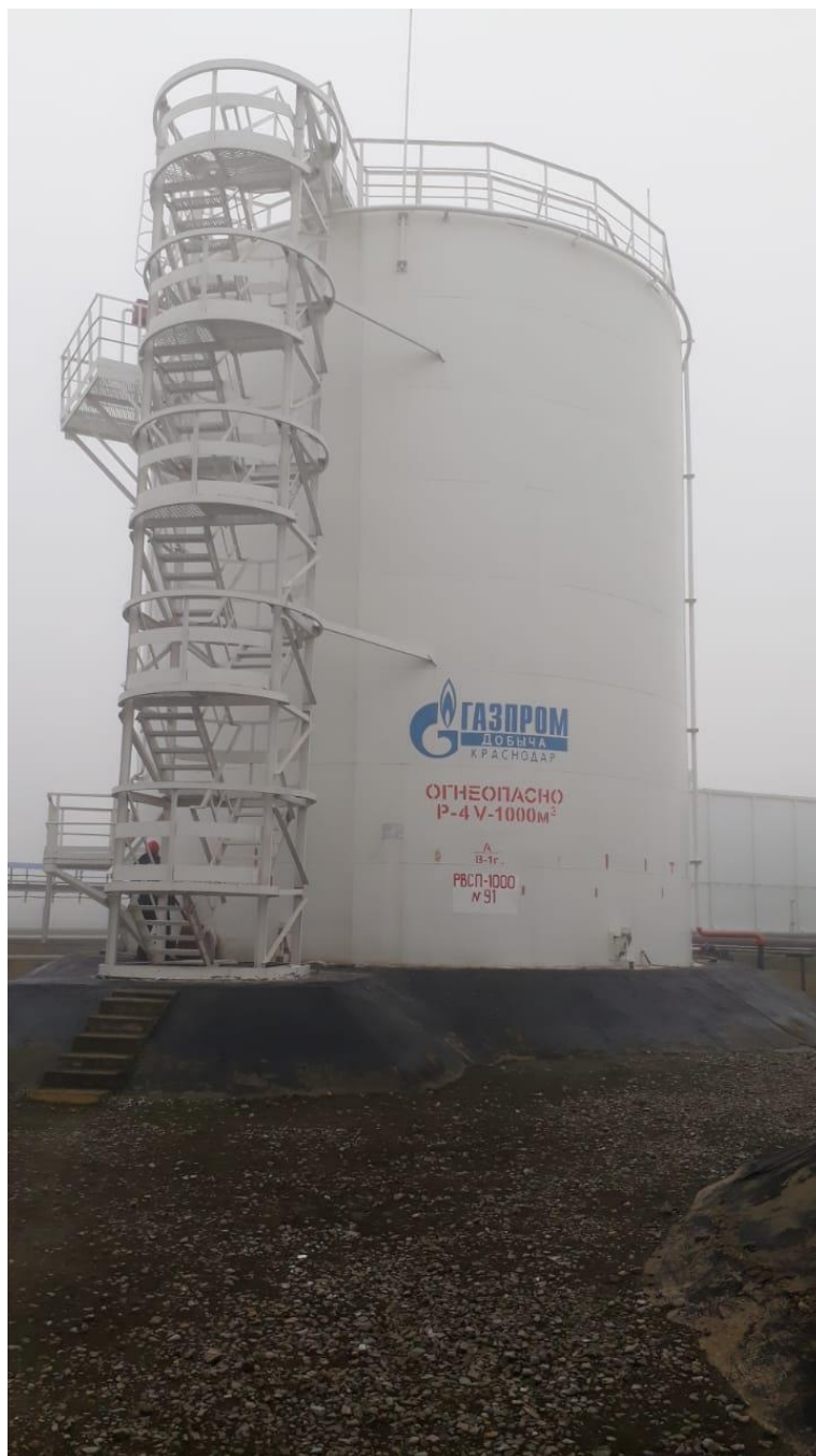
Рисунок 1 - Фотография общего вида резервуара вертикального стального цилиндрического с понтоном РВСП-1000 заводской номер 91.
