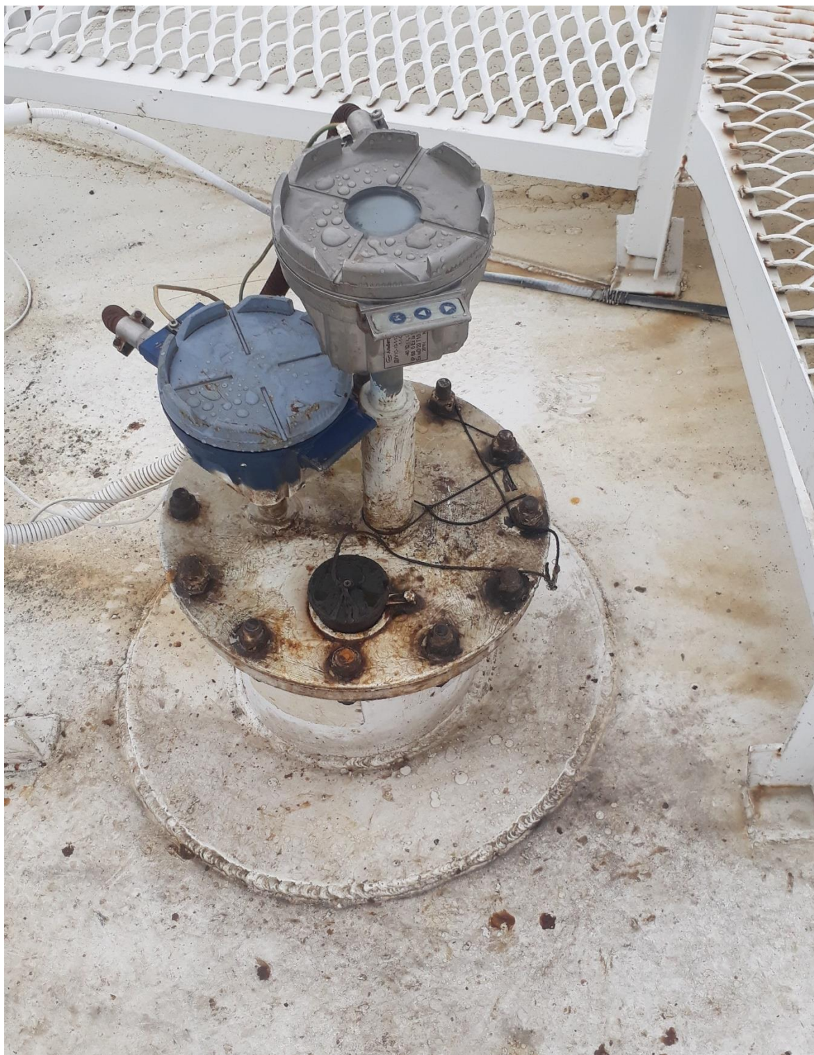
Рисунок 2- Фотография крышки замерного люка резервуара вертикального стального цилиндрического с понтоном РВСП-1000 заводской номер 91.
