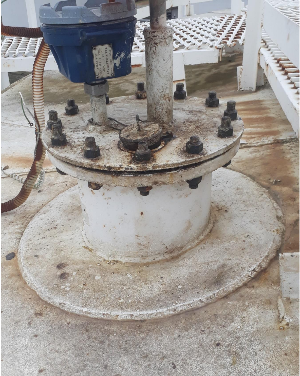
Рисунок 4- Фотография крышки замерного люка резервуара вертикального стального цилиндрического с понтоном РВСП-1000 заводской номер 95.
