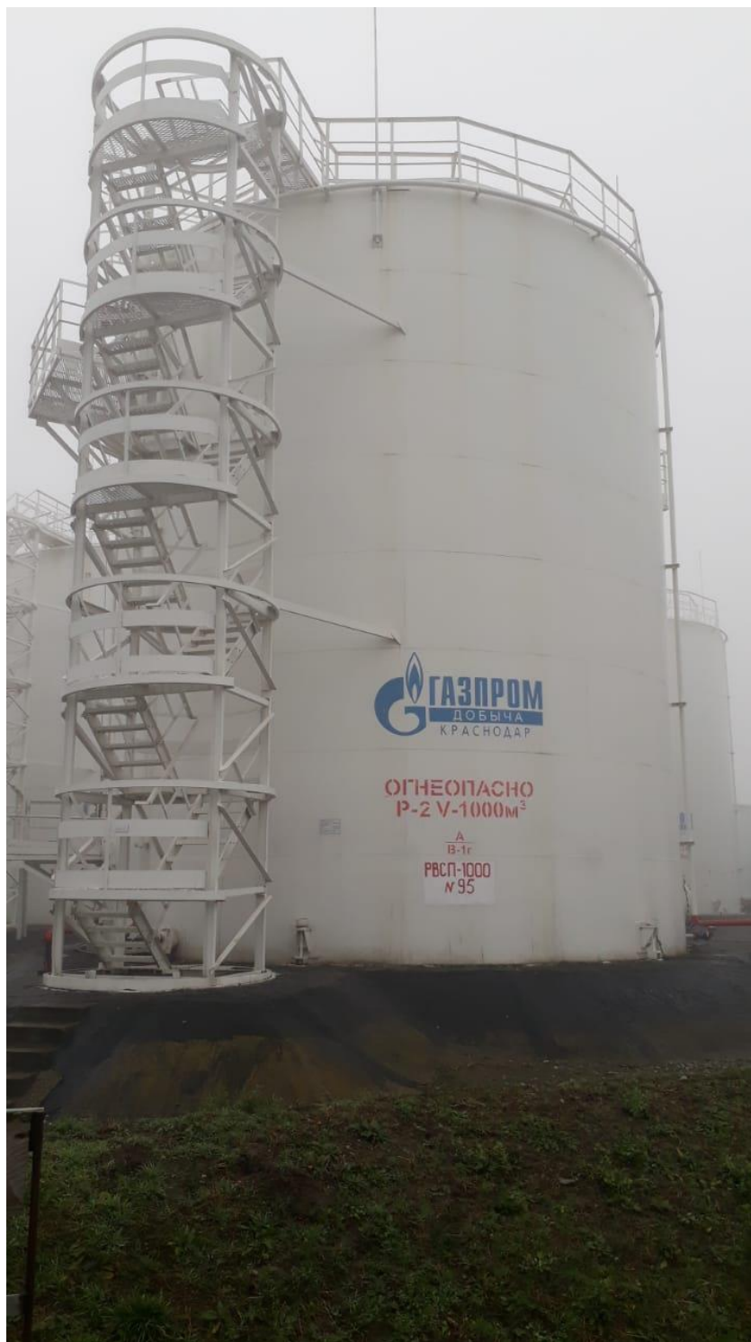
Рисунок 3 - Фотография общего вида резервуара вертикального стального цилиндрического с понтоном РВСП-1000 заводской номер 95.
