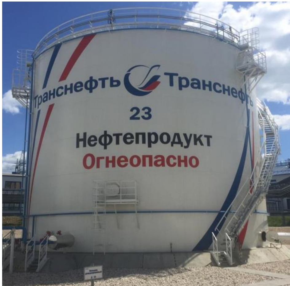
Рисунок 3 – Общий вид резервуара РВСП-5000 зав. № 23
