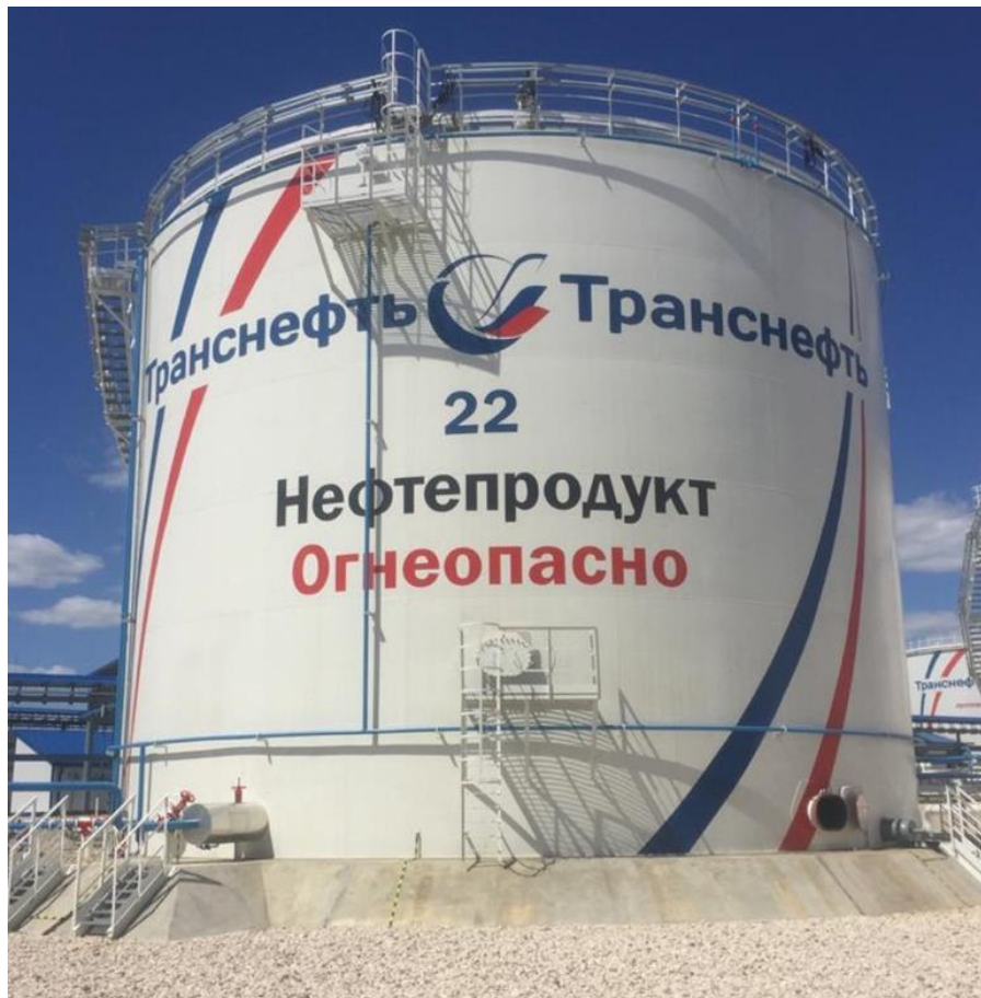
Рисунок 2 – Общий вид резервуара РВСП-5000 зав. № 22
