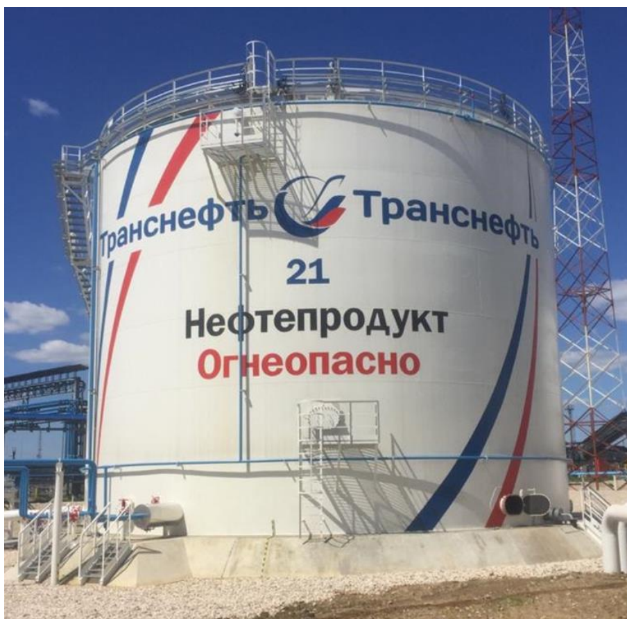
Рисунок 1 – Общий вид резервуара РВСП-5000 зав. № 21
