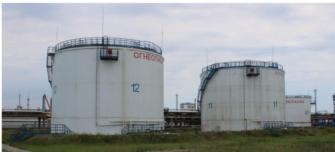
Рисунок 1 – Общий вид резервуаров
