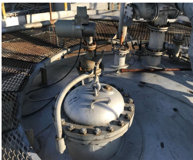
Рисунок 2 – Общий вид резервуаров РИС-600
