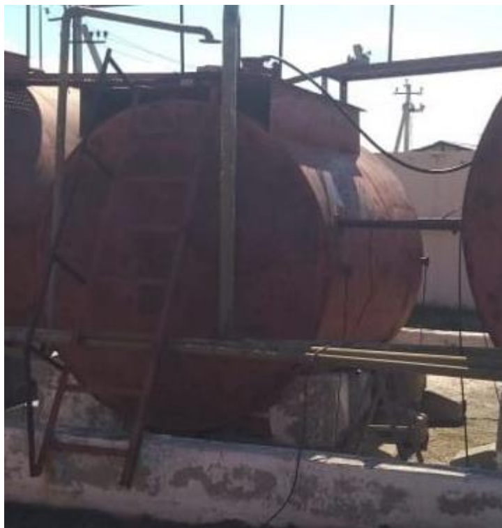
Рисунок 2 – Общий вид резервуара Р-10
