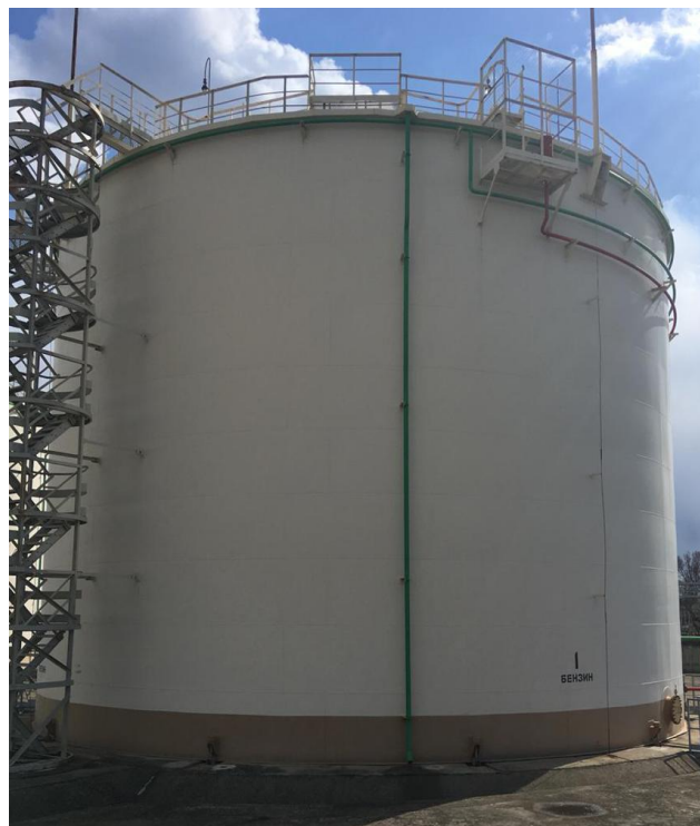
Рисунок 1 - Общий вид резервуаров стальных вертикальных цилиндрических РВС-5000 зав. №№ 1, 2
