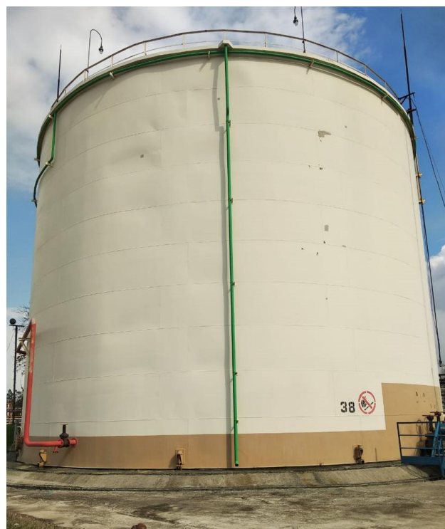
Рисунок 2 - Общий вид резервуаров стальных вертикальных цилиндрических РВС-5000 зав. №№ 35, 38
