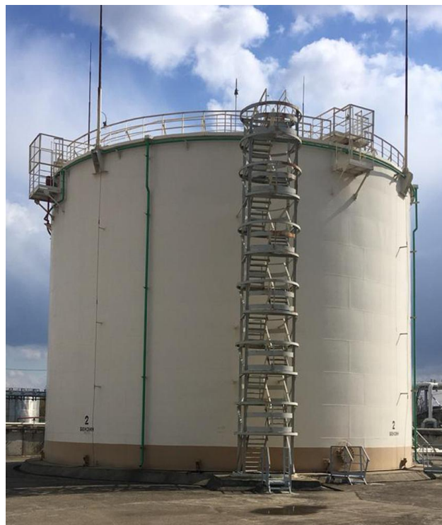
Рисунок 1 - Общий вид резервуаров стальных вертикальных цилиндрических РВС-5000 зав. №№ 1, 2
