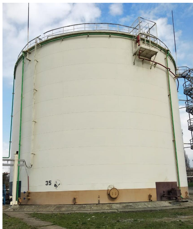
Рисунок 2 - Общий вид резервуаров стальных вертикальных цилиндрических РВС-5000 зав. №№ 35, 38
