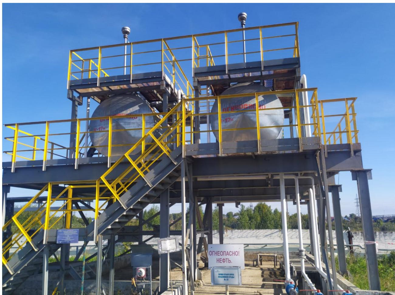
Рисунок 2 – Общий вид резервуаров РГС-20 ЛПДС «Кропачево»
