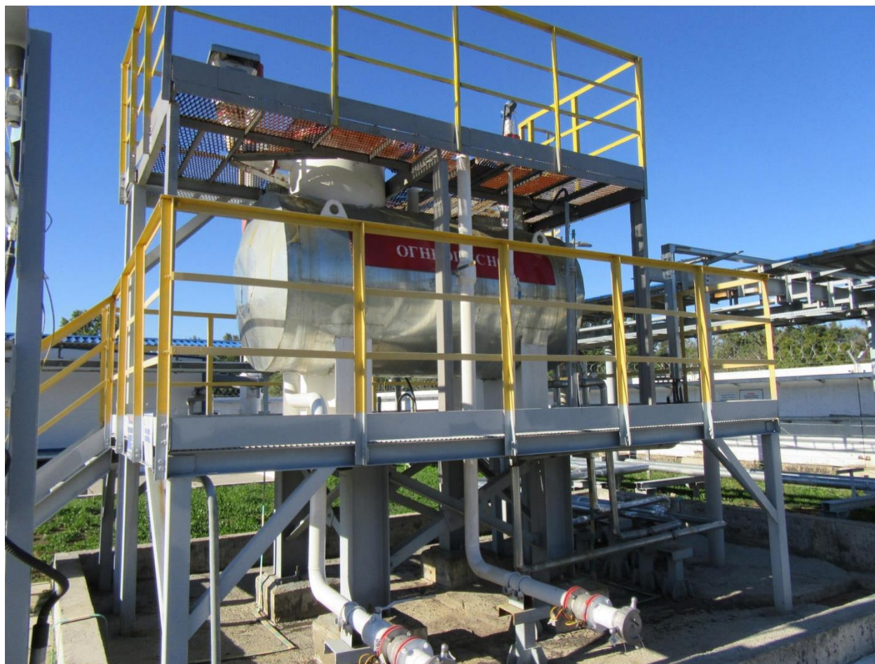
Рисунок 2 – Общий вид резервуара РГС-4
