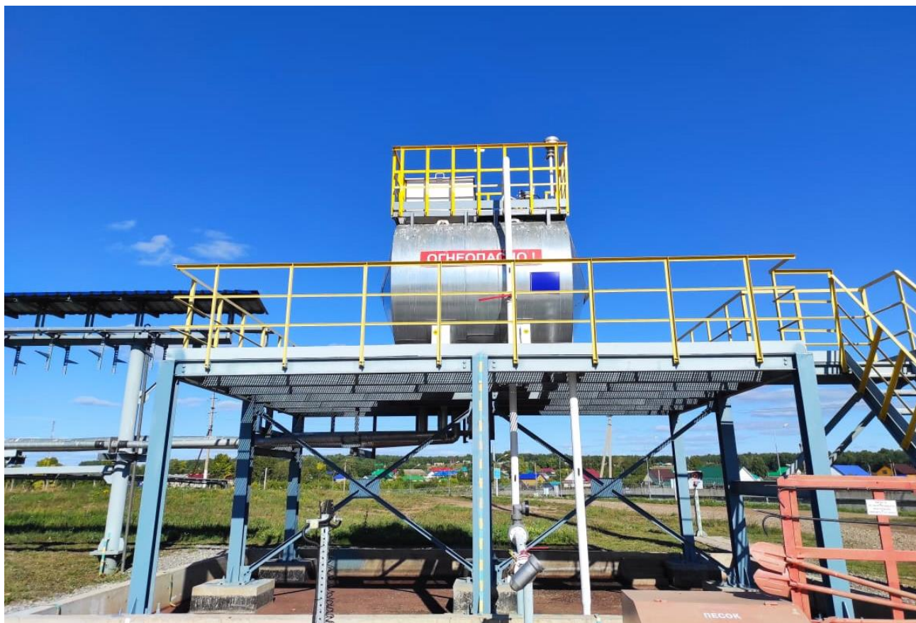
Рисунок 3 – Общий вид резервуара РГС-10
