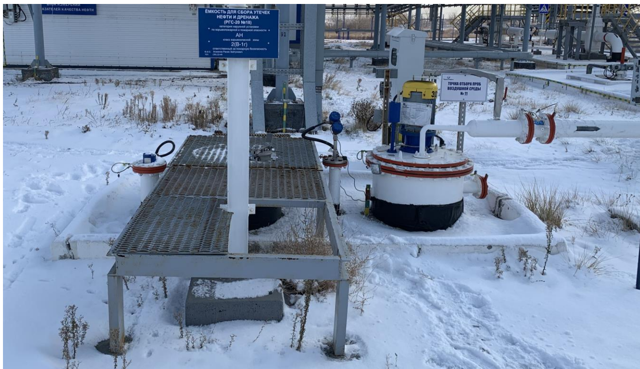
Рисунок 4 – Общий вид резервуара РГС-20
