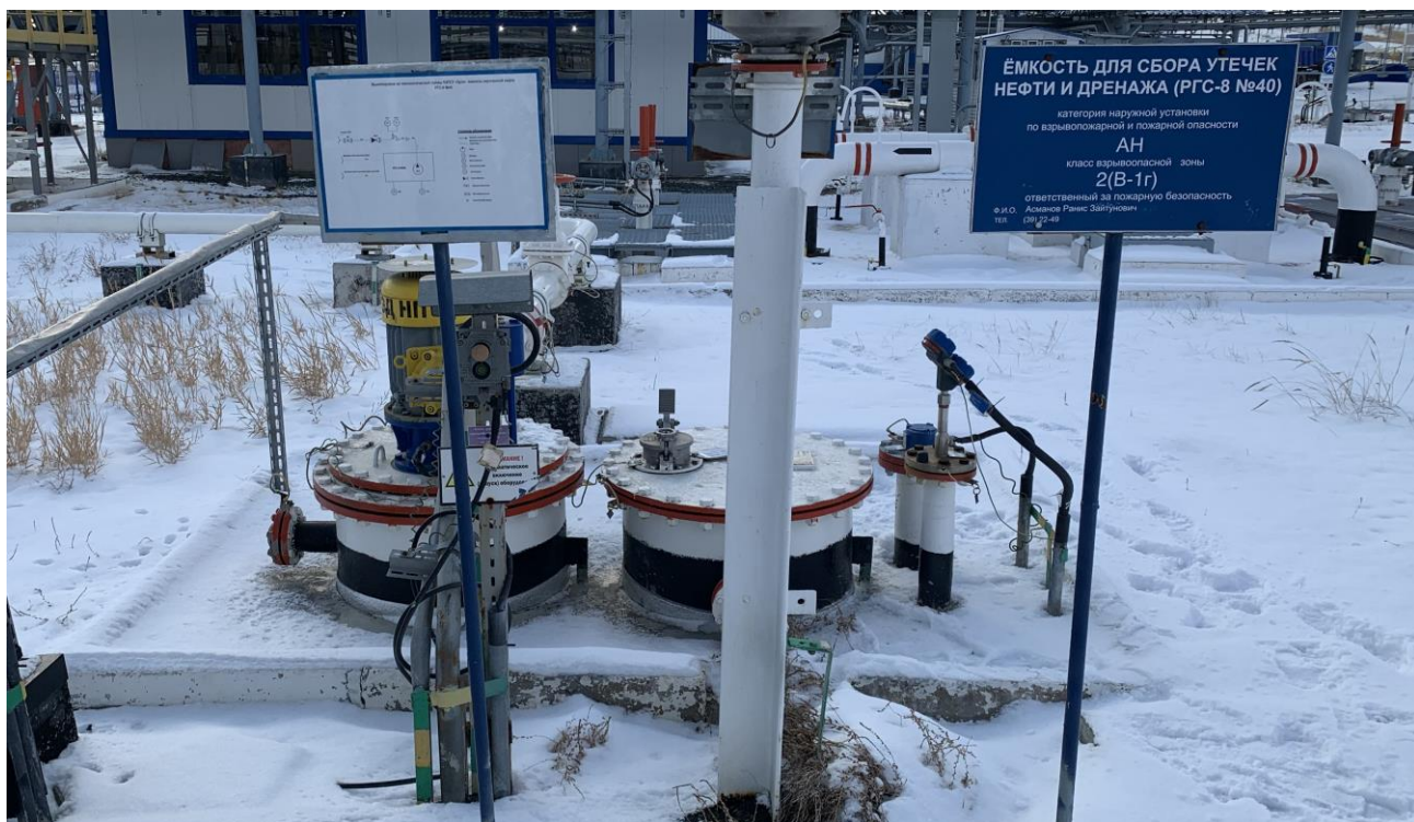
Рисунок 2 – Общий вид резервуара РГС-8
