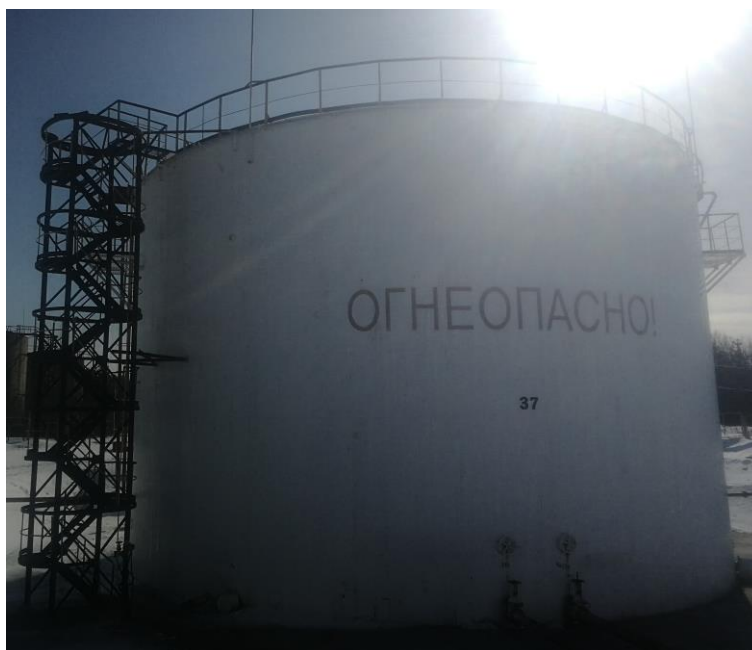
Рисунок 1 – Общий вид резервуаров
