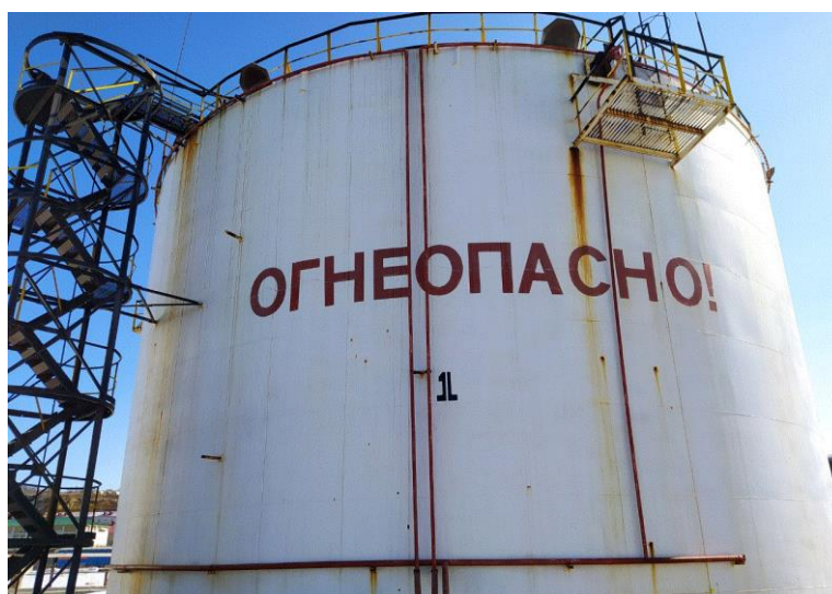
Рисунок 1 – Общий вид резервуаров РВСП-3000
