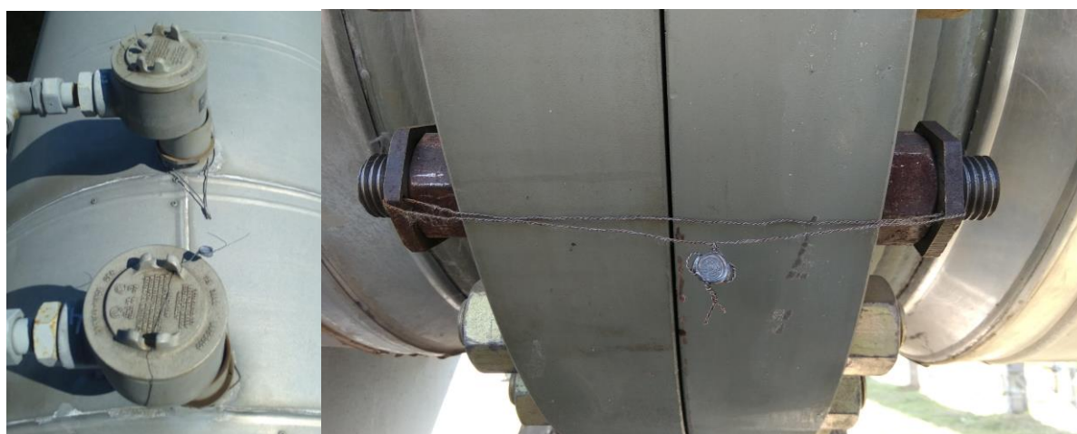
Рисунок 2 – Схема пломбировки детекторов и фланцевых соединений
