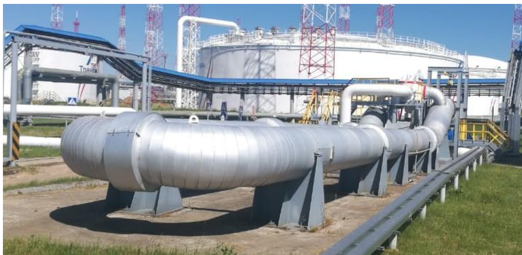
Рисунок 1 – Общий вид установки поверочной трубопоршневой двунаправленной
