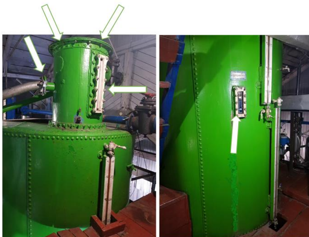
Рисунок 2 – Схема пломбировки мерника ММВ-750У, зав.№ 3 от несанкционированного доступа, обозначение места нанесения знака поверки
