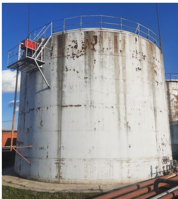
Рисунок 1 – Общий вид резервуара РВС-1000
