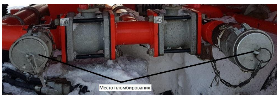
Рисунок 2 - Схема пломбировки от несанкционированного доступа
